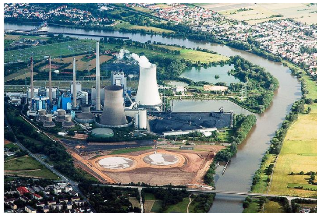
Kraftwerk Staudinger Großkrotzenburg
