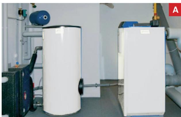
**A** Chaudière à condensation au gaz/au mazout moderne
