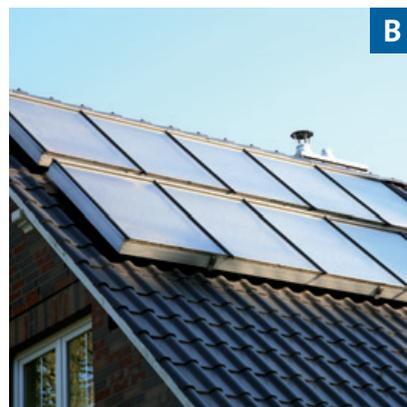
**B** Réchauffement solaire de l'eau potable et assistance du chauffage
