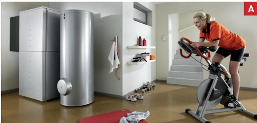
**A** Pompe à chaleur air-eau avec ballon tampon et ballon d'eau chaude chauffé indirectement
