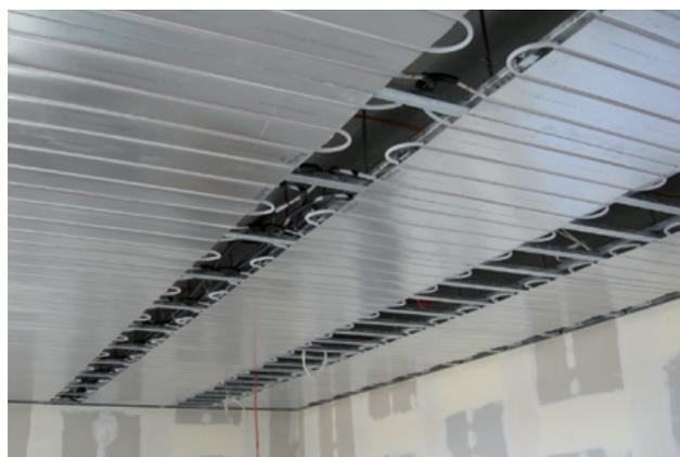
Fig. 75 : Double fonction : chauffage et refroidissement dans le plafond
