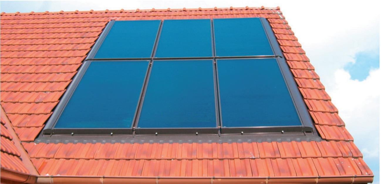
Fig. 56 : Exemple pratique pour l'utilisation de capteurs plats héliothermiques
