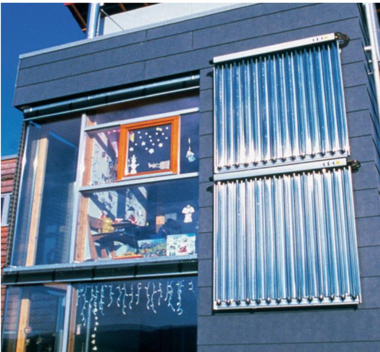
Fig. 53 : Exemple pratique pour l'utilisation de capteurs à tubes sous vide héliothermiques
