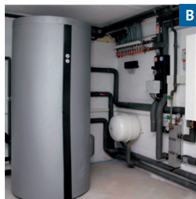
B Moderna caldaia a condensazione a gasolio/gas
