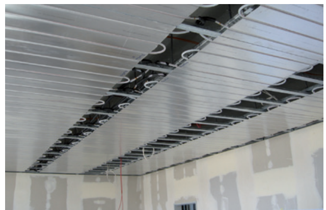
Fig. 75: Duplice funzione: riscaldamento e raffreddamento nel soffitto
