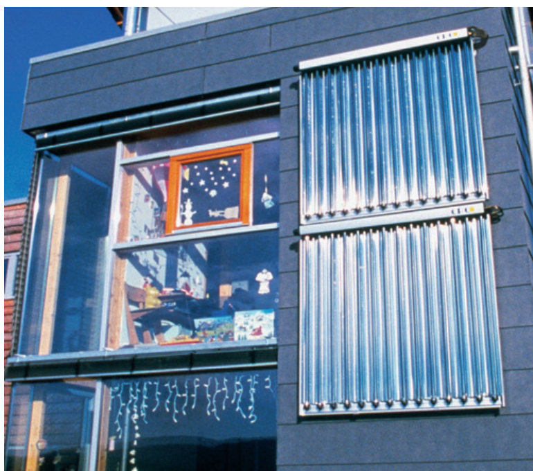
Fig. 53: Esempio di collettori a tubi sottovuoto in impianti solari termici
