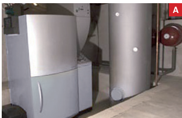
A Caldaia a legna-pellet
