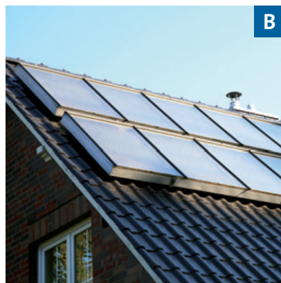
Riscaldamento acqua calda potabile e supporto riscaldamento ambienti a energia solare
