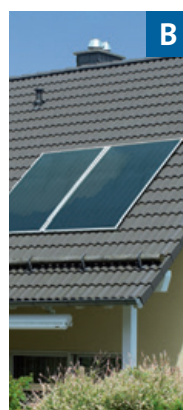
B Riscaldamento acqua potabile da energia solare
