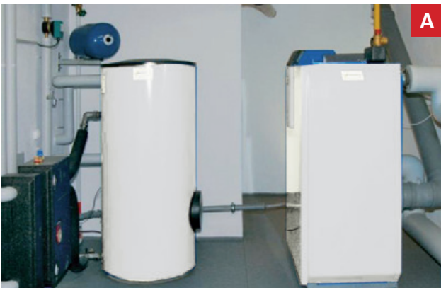
Moderna caldaia a condensazione a gas/ gasolio
