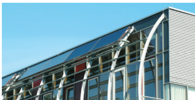
Fig. 51: Esempi di impianti: collettore piano
