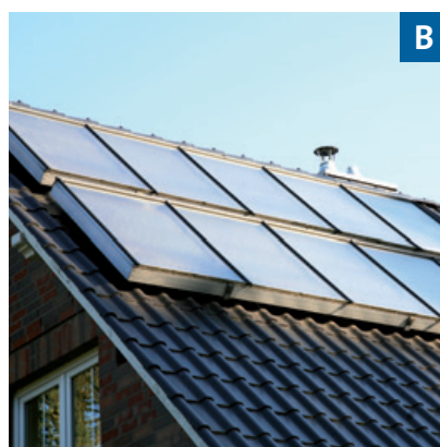
B Riscaldamento acqua calda potabile e supporto riscaldamento ambienti a energia solare
