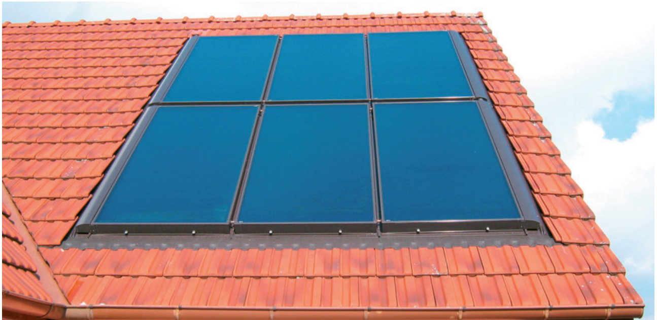
Fig. 56: Esempio pratico per l'utilizzo di collettori piani in impianti solari termici
