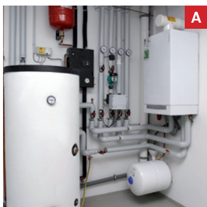
A Caldaia a condensazione di tipo moderno
