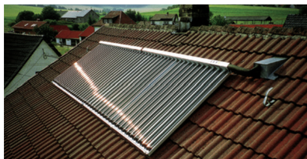
Fig. 52: Esempi di impianti: collettore a tubi sottovuoto
