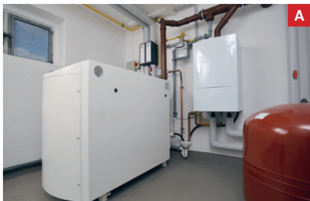
Mini impianto di cogenerazione calore-elettricità
