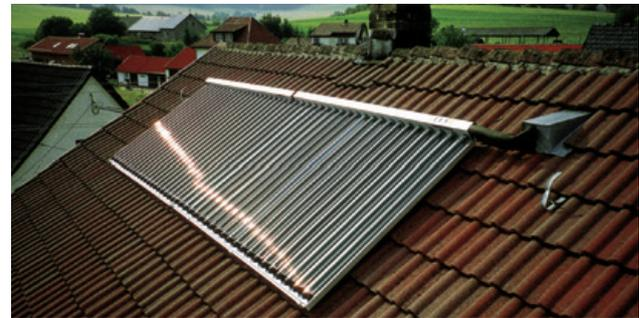
Fig. 52: Ejemplos de instalaciones – Colector de tubos de vacío
