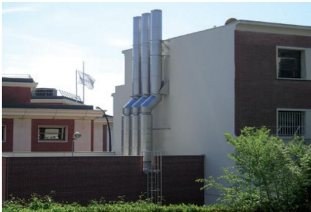
Fig. 94: Sistemas de gases de escape de acero inoxidable en instalaciones de calefacción que funcionan con motores de combustión
