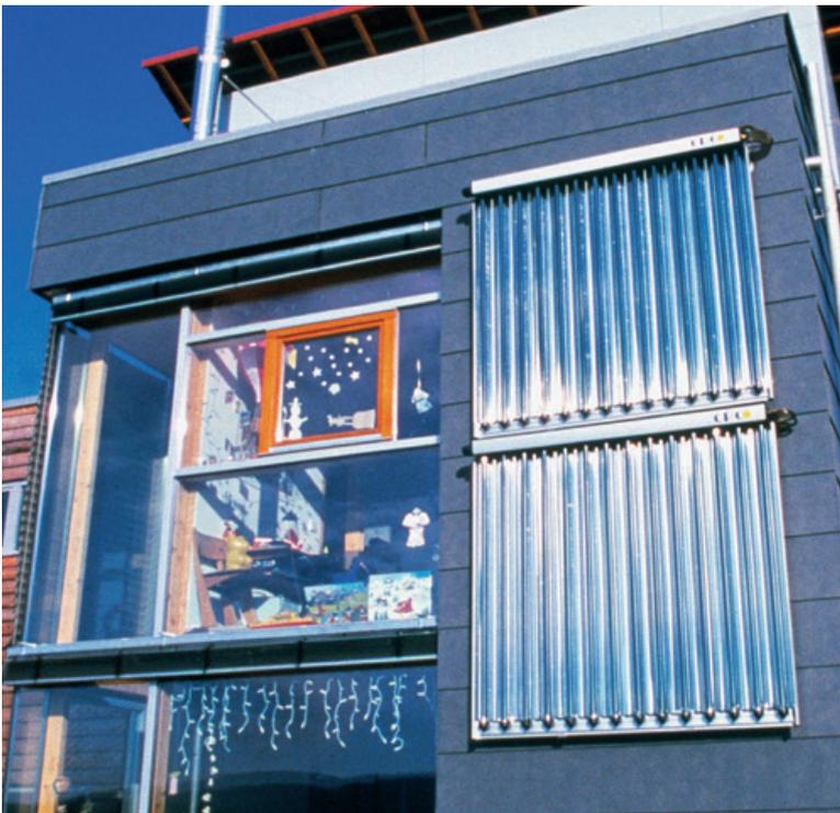
Fig. 53: Ejemplo práctico para la aplicación de colectores de tubos de vacío termosolares
