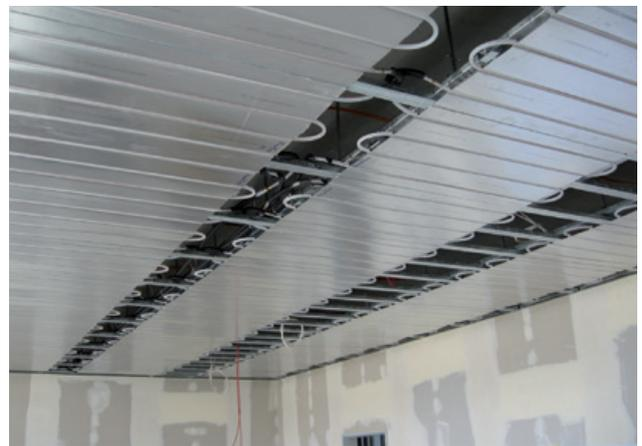
Fig. 75: Doble función: calefacción y refrigeración en la zona del techo
