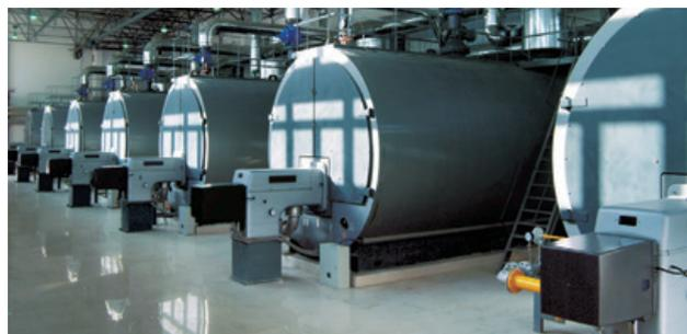
Fig. 100: Central de calefacción consistente en siete generadores de agua caliente con una potencia total de 105 MW
