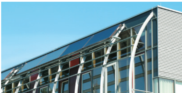
Abb. 51: Anlagenbeispiel – Flachkolloktor
