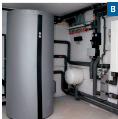
B Moderner Gas-/Öl-Brennwertkessel mit Warmwasserspeicher
