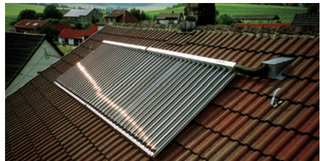
Abb. 52: Anlagenbeispiel – Vakuumröhrenkolloktor
