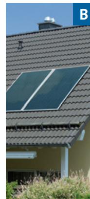
B Solare Trinkwassererwärmung
