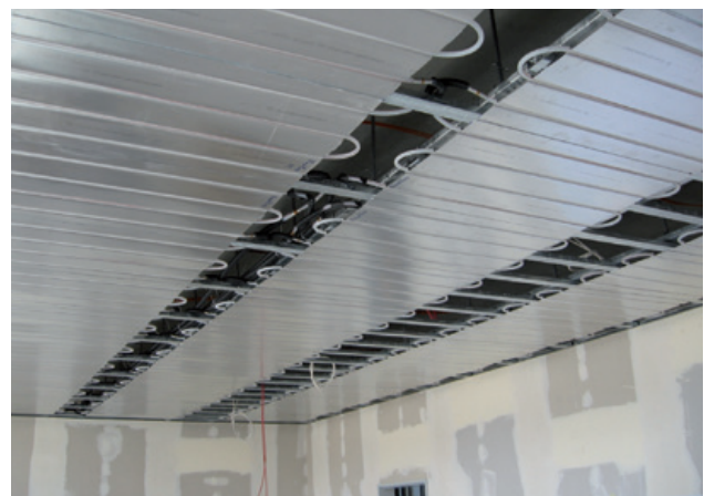
Abb. 75: Doppelfunktion: Heizen und Kühlen im Deckenbereich
