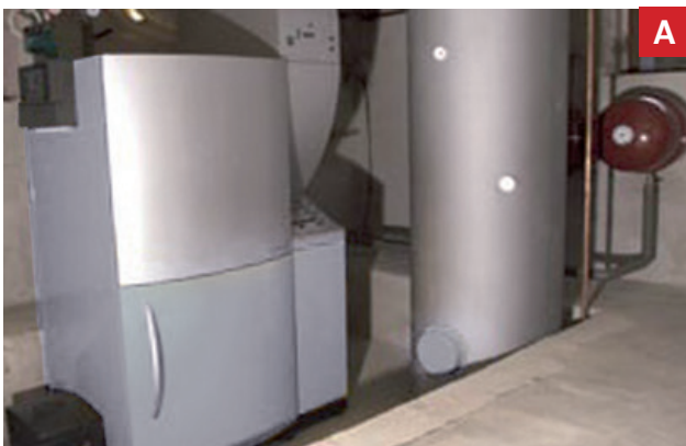
A Holz-Pelletkessel mit Pufferspeicher
