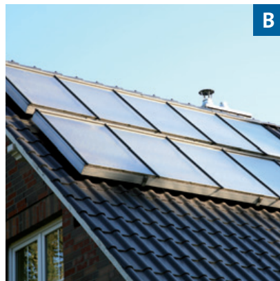
B Solare Trinkwassererwärmung und Heizungsunterstützung
