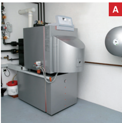
A Moderner Öl-Brennwertkessel
