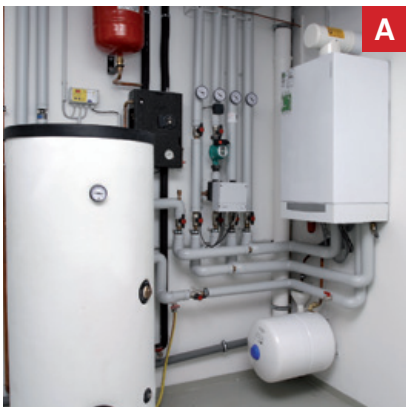
A Moderner Gas-Brennwertkessel
