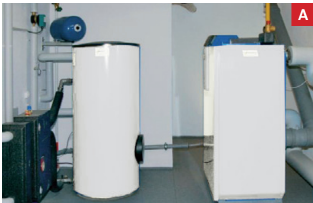
A Moderner Gas-/ Öl-Brennwertkessel
