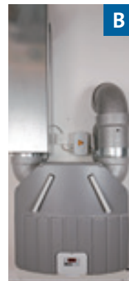
B 可控制的室內通風系統 提供熱能回收功能
