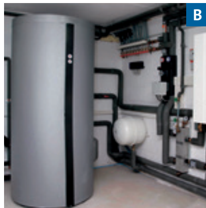
B 現代燃氣／燃油冷凝鍋爐
