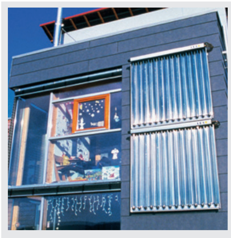
圖 53：太陽熱能真空管集熱器的實際應用範例
