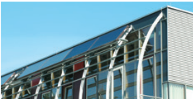
圖 51：系統範例——平板式集熱器
