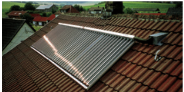
圖 52：系統範例——真空式集熱器
