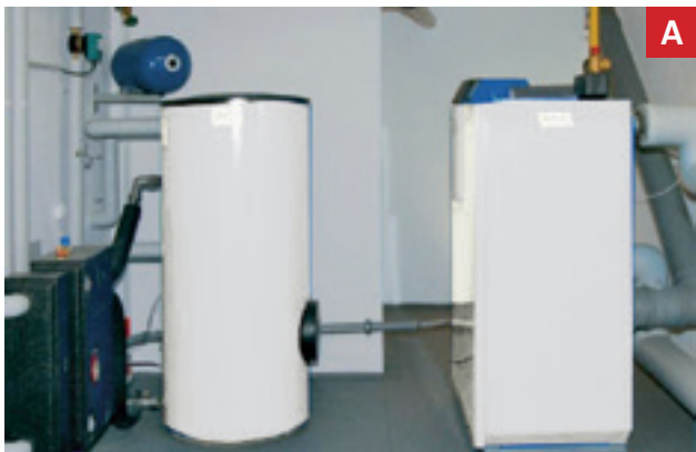
A 現代燃氣/ 燃油冷凝鍋爐
