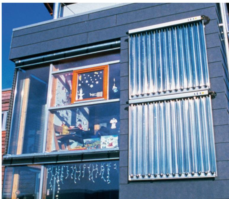
Рис. 53: Практический пример использования вакуумного коллектора
