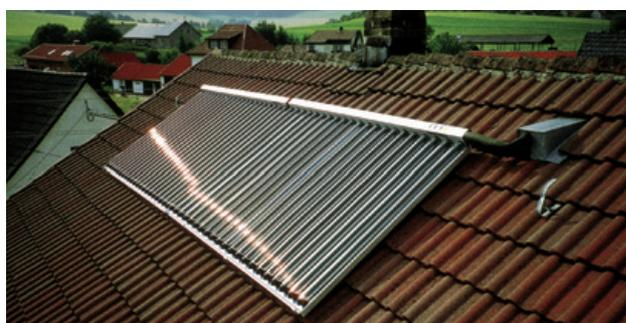
Рис. 52: Примеры установок – Коллектор с вакуумными трубками
