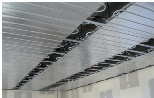
Рис. 75: Двойная функция: Отопление и охлаждение в области потолка
