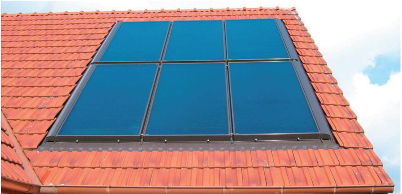
Рис. 56: Практический пример использования плоского коллектора
