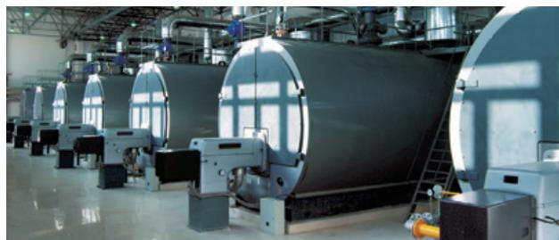
Рис. 100: Теплоцентральный, состоящая из семи генераторов горячей воды общей мощностью 105 мВт
