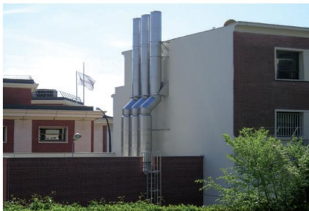
Рис. 94: Системы выпуска ОГ из нержавеющей стали для установок сжигания топлива с двигателем внутреннего сгорания
