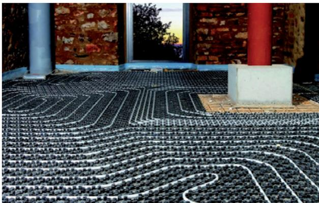
Рис. 72: В старых зданиях системы панельного отопления/охлаждения также обеспечивают удобство и комфорт
