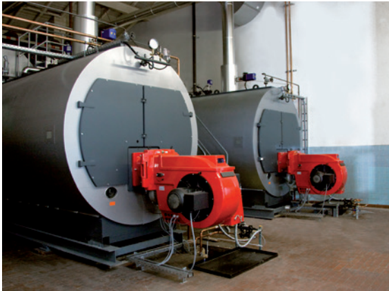
Dampfkessel mit Leistungen von je 6 t/h Steam boilers with output of 6 t/h each
