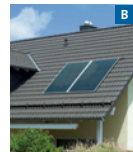
Solare Trinkwassererwärmung Solar thermal system for domestic hot water
